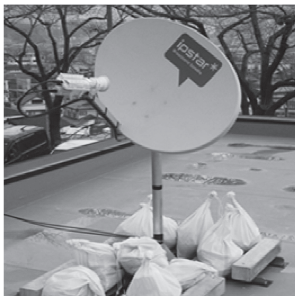
図2.1 IPstar用84cmパラボラアンテナ
