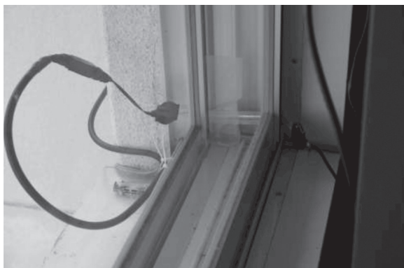
図3.4 薄型のLANケーブルを使用した配線
