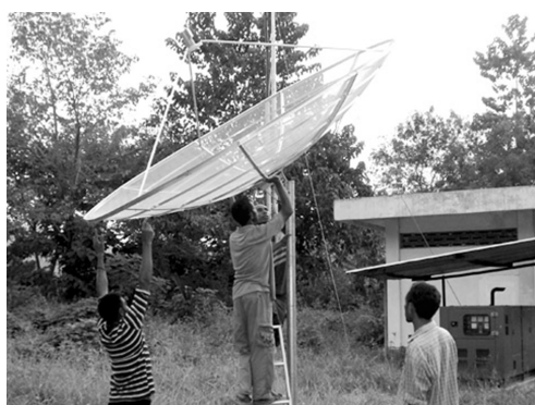
図 2.3. AI3 パラボラアンテナの設置
