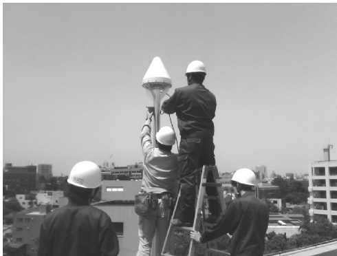
図 2.2. 基準局アンテナの設置風景
