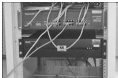
図 4.3. DVB-RCS モデム (中央にある約 2U の黒色の機器)
