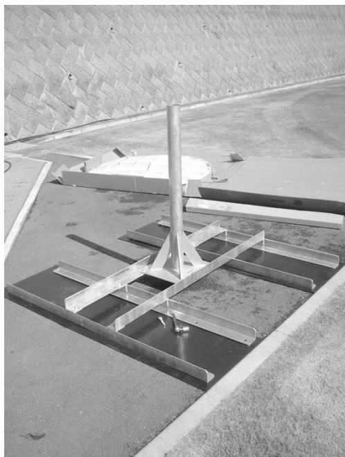
図 7.4. アンテナマスト
