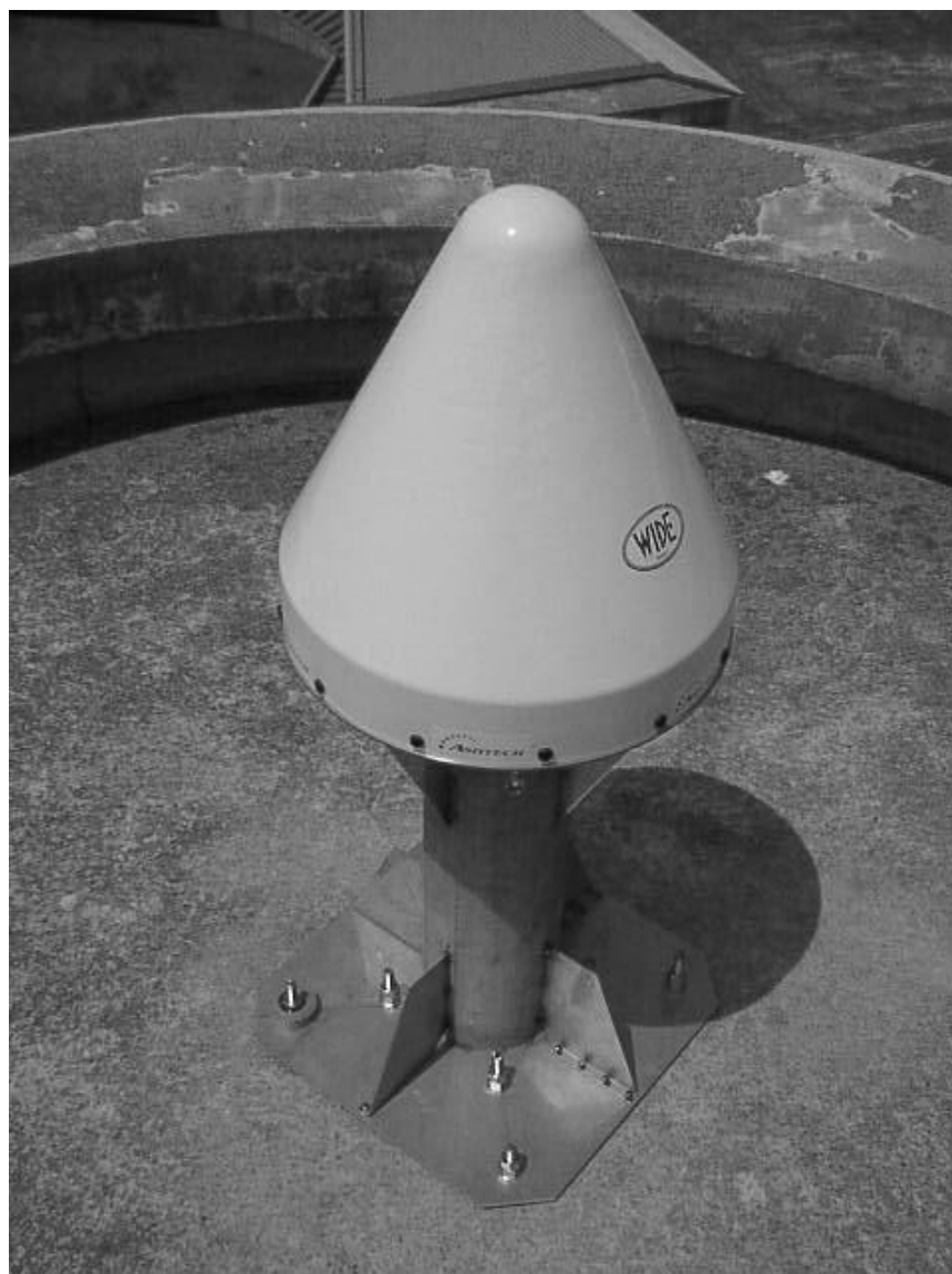
図 4.1: SFC 屋上に設置されたアンテナ
